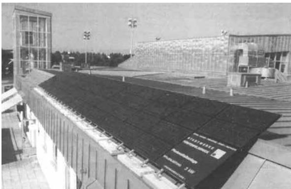
Photovoltaikanlage auf dem Dach des Hallenbades
