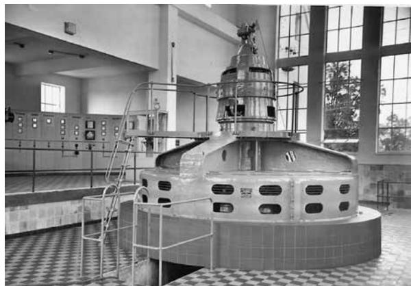
*Neuer Maschinensatz im Kraftwerk Obermühle mit der ersten modernen Kaplan-Turbine (1949)*
