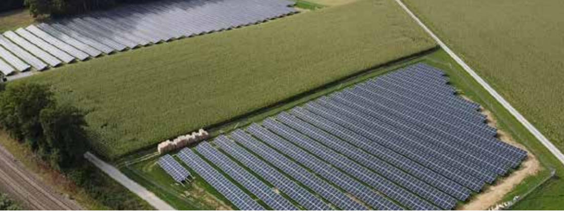
PV-Freiflächen Kottgeisering I und II leisten einen wichtigen Beitrag zur Umsetzung der Energiewende in der Region.
